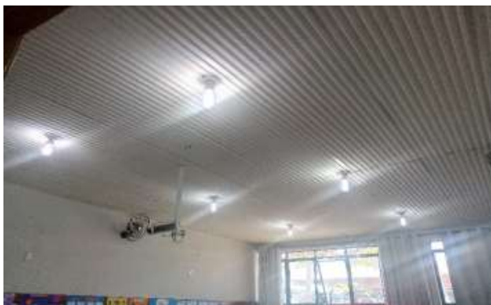
Figura 38 – Foto do sistema de iluminação com lâmpadas CFL de uma das salas da UE-1
