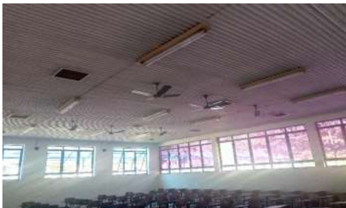
Figura 38 – Foto do sistema de iluminação com lâmpadas CFL de uma das salas da UE-1
