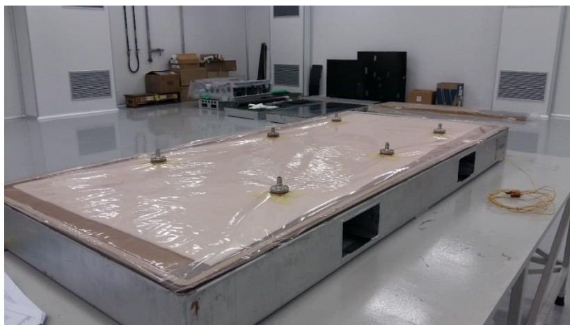
Figura 33 – Terceira etapa da laminação: cobertura do molde com a manta, colagem da bolsa de vácuo e inserção dos bicos de vácuo e termopares.
