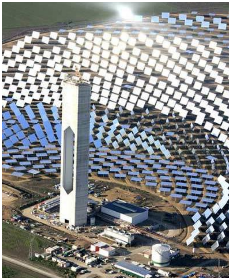
Figura 2.21 – Usina PS10 em Seville, Espanha (POWER TECHNOLOGY, 2019).
