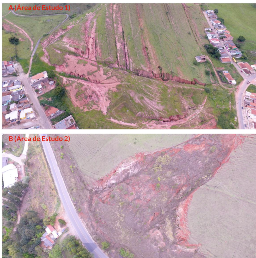
Figura 7. a) Voçoroca na área de estudo 01 e b) Voçoroca na área de estudo 02. Fonte: Autor (2020).
