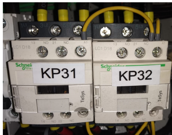
Figura 30 – Contadores de pré-carga
