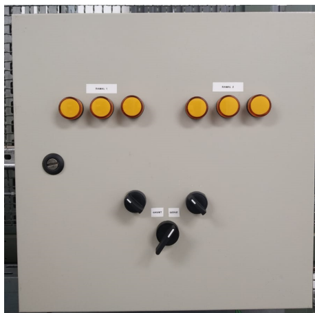
Figura 67 – Painel de comando das chaves a óleo
