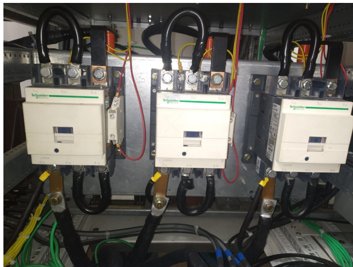
Figura 31 – Contatores CA já instalados no equipamento
