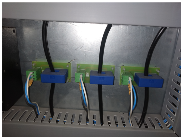
Figura 40 – Sensores responsáveis pela medição da corrente dos bancos de baterias de uma fase
