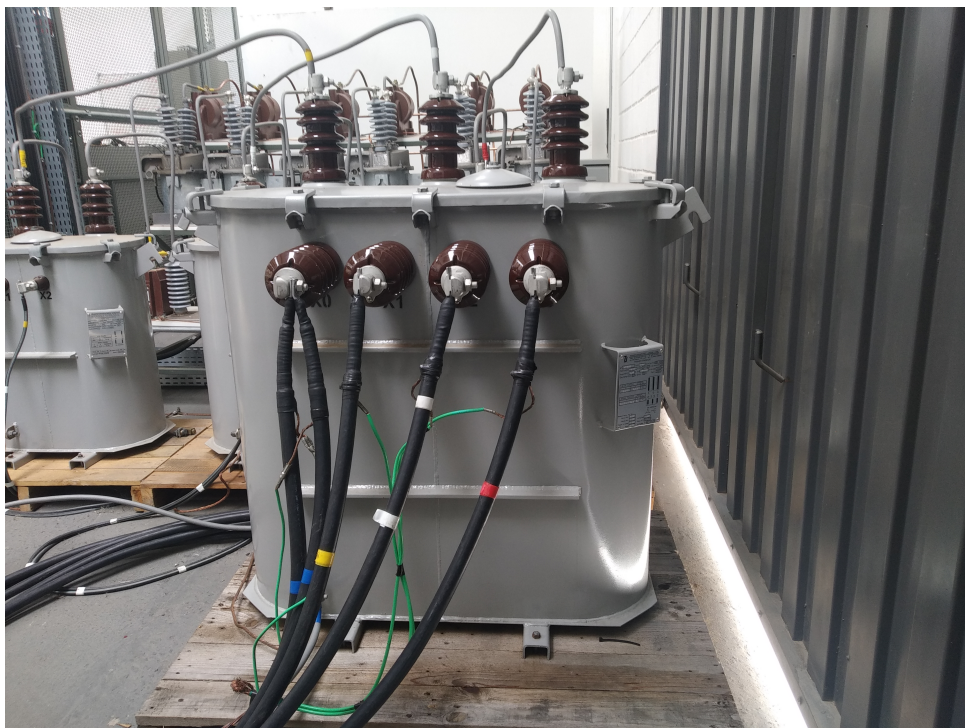
Figura 20 – Transformador de acoplamento instalado
