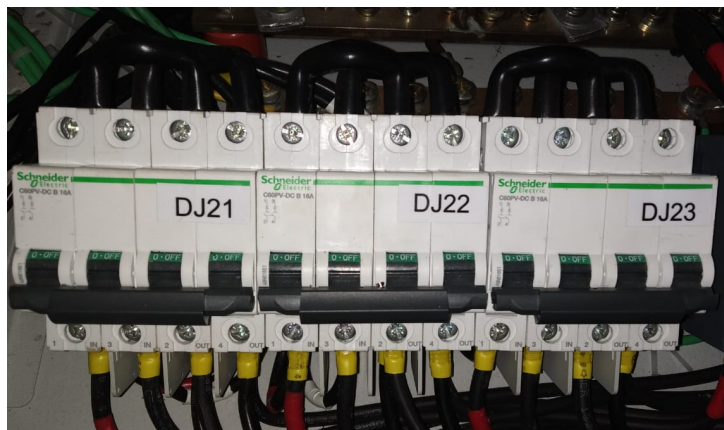
Figura 25 – Disjuntor CC - C60PV-DC 2P 16A
