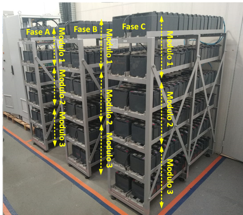
Figura 19 – Estruturas dos Bancos de Baterias
