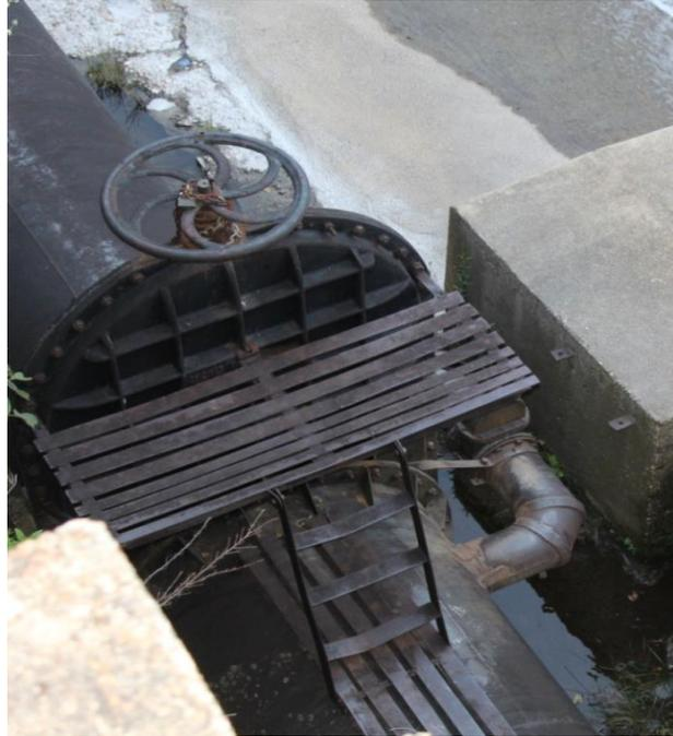
Figura 15 – Detalhe da válvula gaveta na entrada da tubulação de baixa pressão
