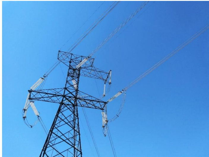
Figura 16 – Exemplo de estrutura de 500 kV inspecionada em campo. Fonte: Próprio autor
