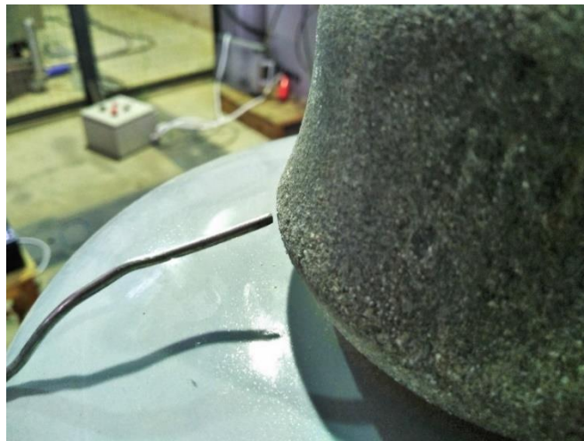
Figura 24 – Detalhe do gap formado entre o fio e a campânula do isolador. Fonte: Próprio autor
