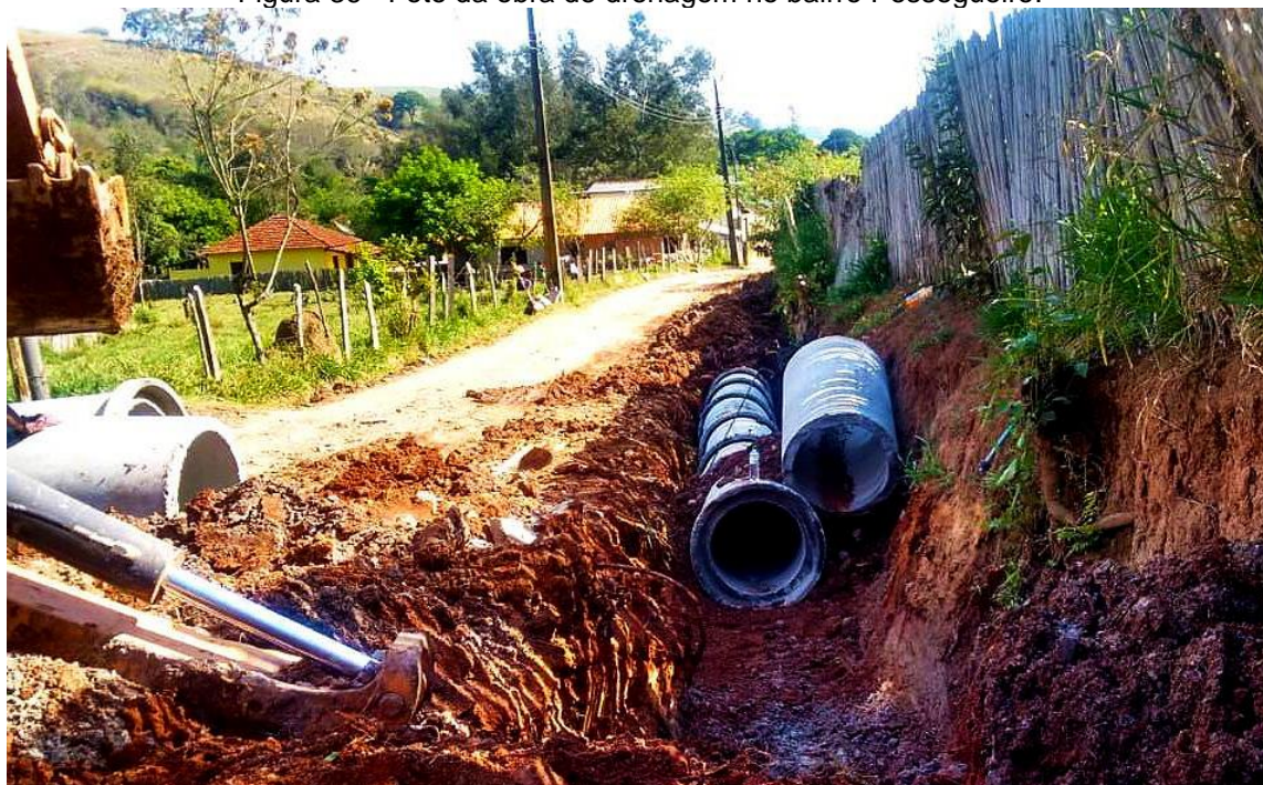
Figura 36 - Foto da obra de drenagem no bairro Pessegueiro.
