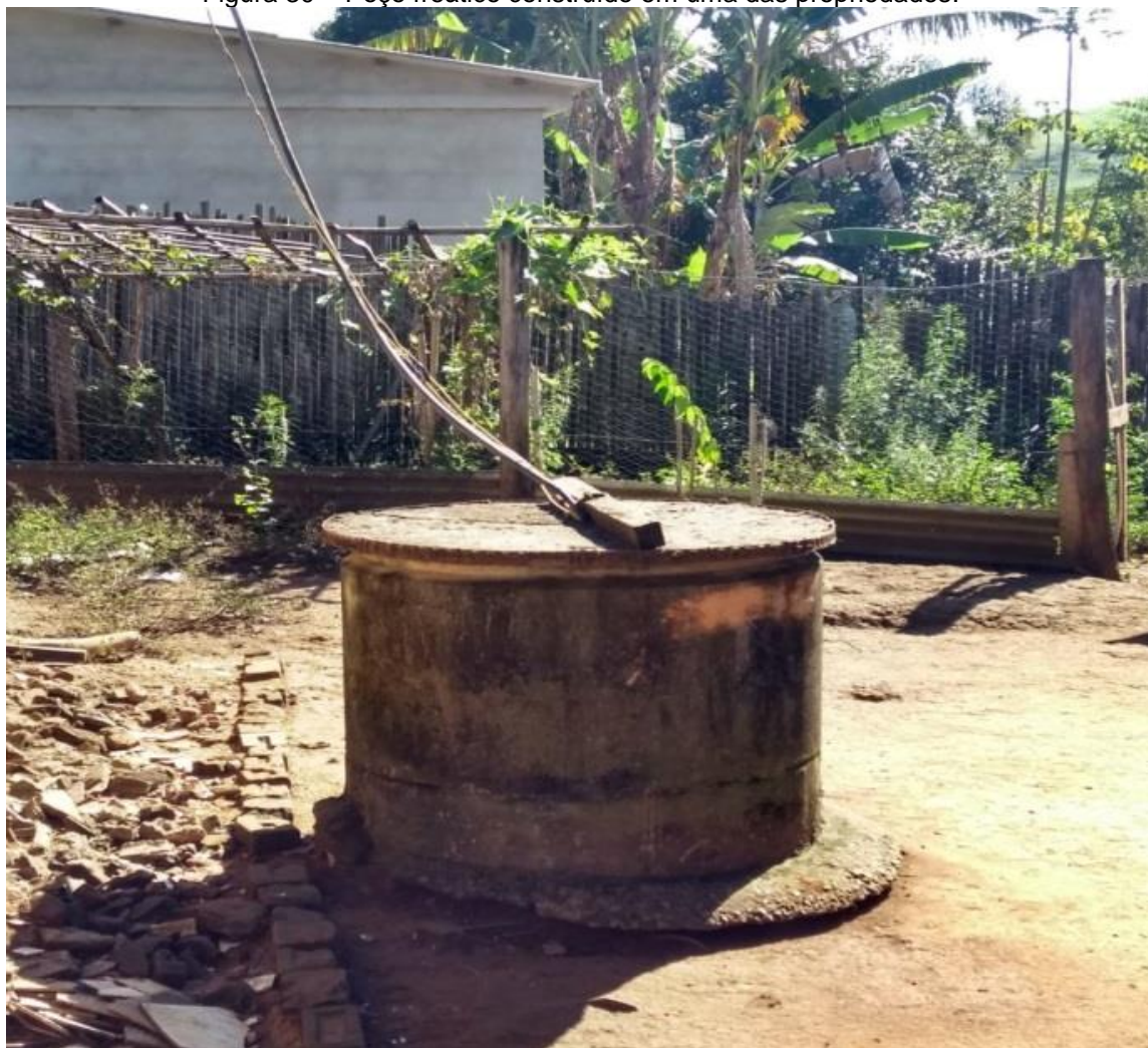
Figura 30 – Poço freático construído em uma das propriedades.
