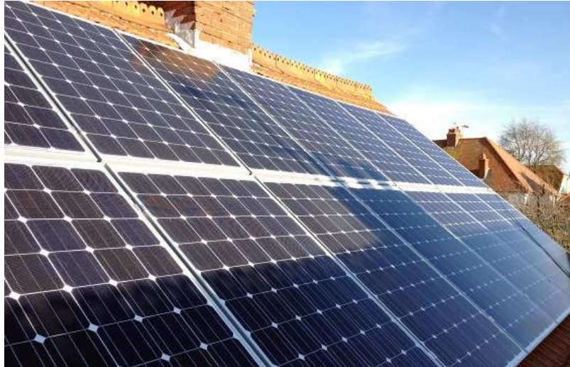
Figura 16: Módulo fotovoltaico sob o efeito de uma sombra
