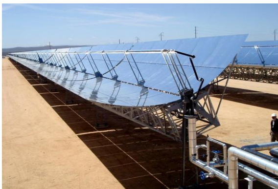
Figura 3 – Concentrador Cilíndrico-parabólico
