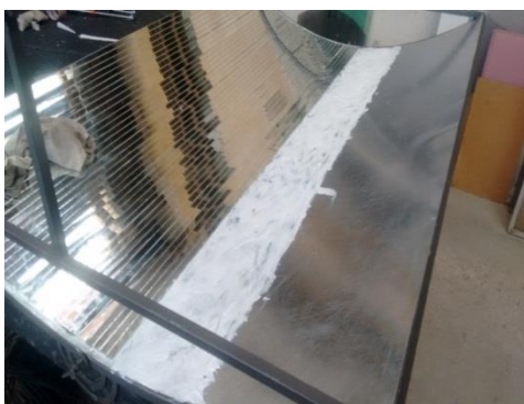
Figura 29 – Fixação dos espelhos
