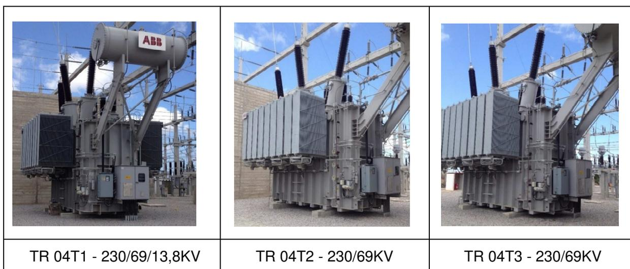
Figura 7-3 – Fotografia dos Transformadores da SE Aquiraz II
