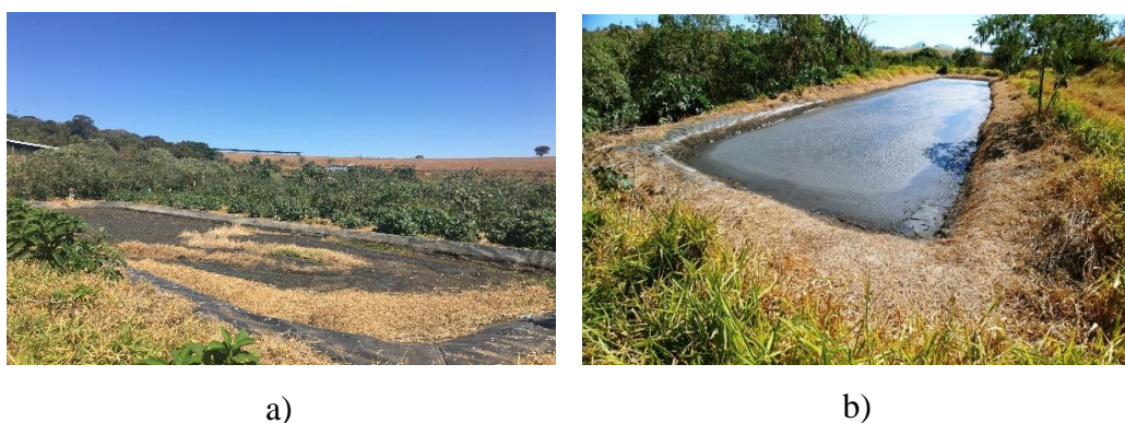
Figura 13 - Tratamento dos dejetos de suínos no município de Cachoeira de Minas a) 1ª lagoa de fertilização. b) 2ª lagoa de fertilização
