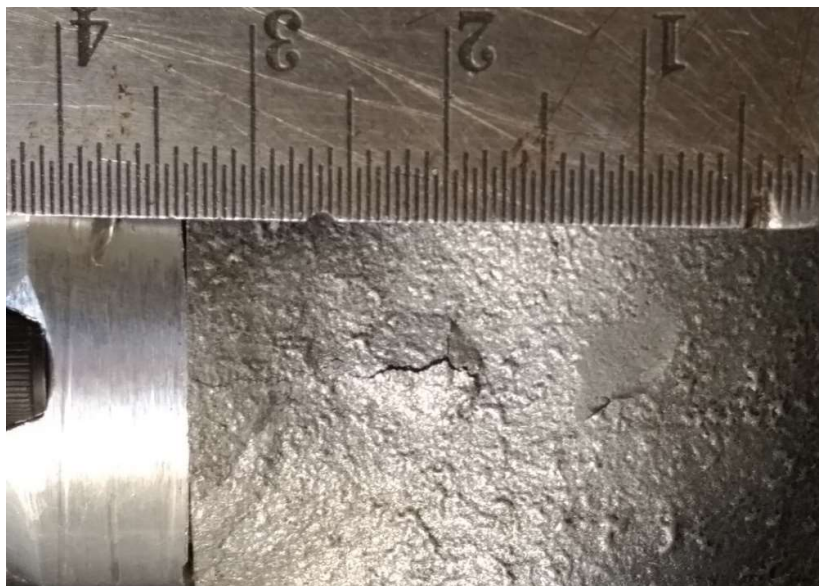
Figura 33 - Dimensão da rachadura na face frontal da sede de válvula
