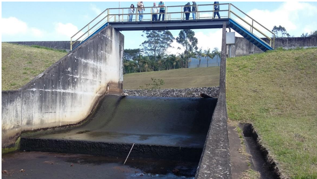
Figura 23 – Vertedouro da Barragem do Cipó, visão de jusante para montante.
