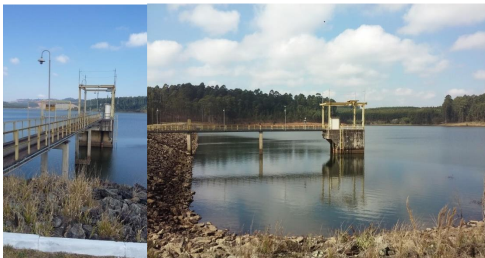
Figura 25 – Tomada d'água da Barragem do Cipó.
