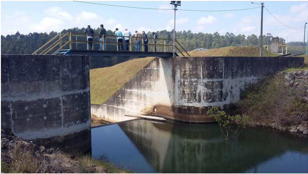
Figura 22 – Vertedouro da Barragem do Cipó, visão de montante para jusante.
