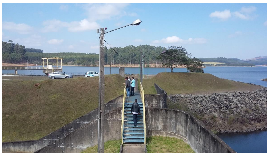
Figura 21 – Ombreira esquerda, onde se encontra o vertedouro, desincorporado da barragem.
