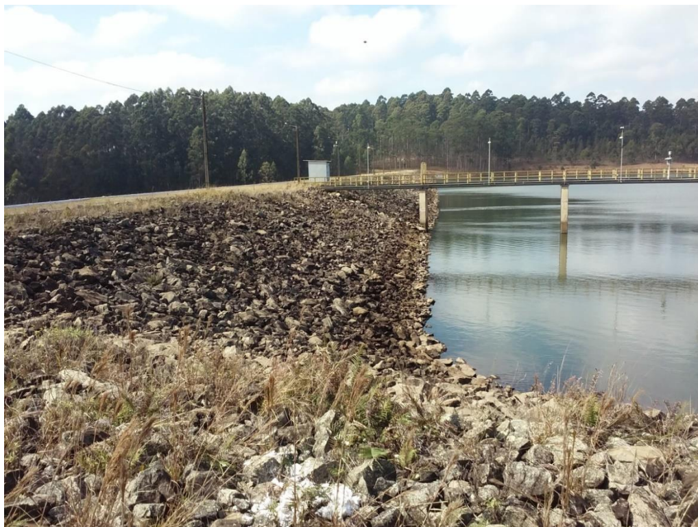
Figura 20 – Barragem, em aterro compactado, da Barragem do Cipó.
