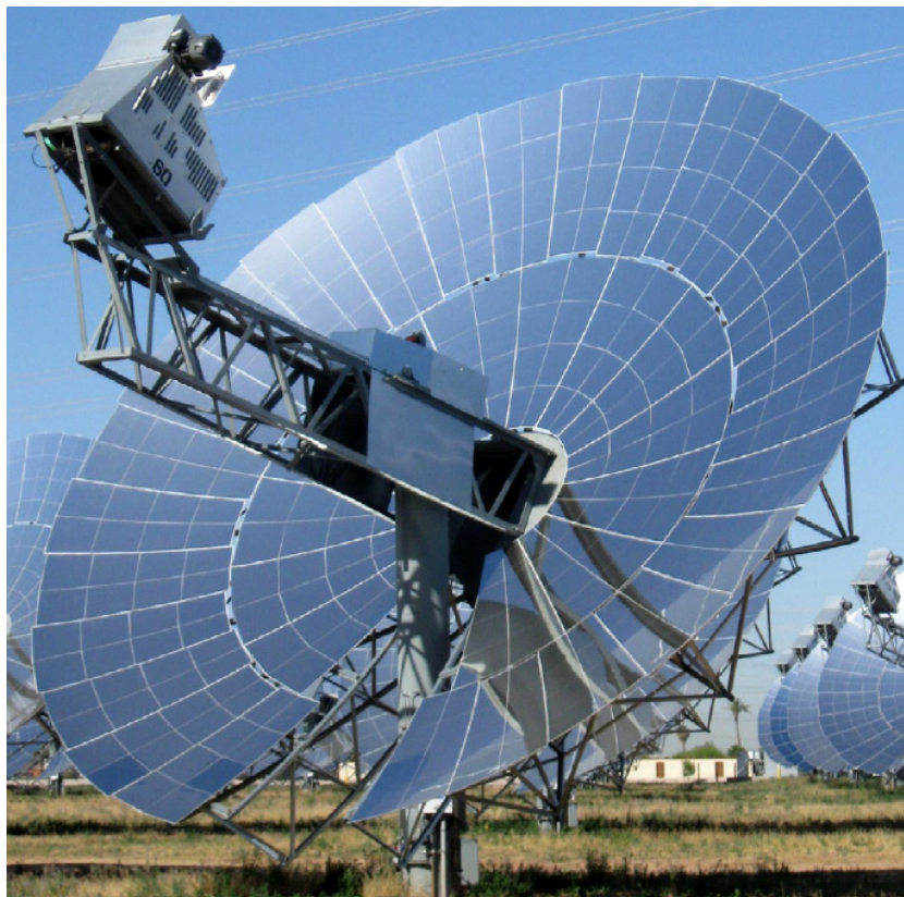
Figura 2.31 – Planta Solar de Maricopa, Geração Heliotérmica com Sistemas Dish Stirling. Fonte: (VARUN e PRAKASH, 2016).
