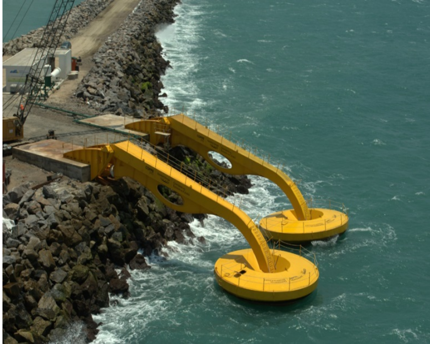
Figura 2.10 - Exemplo de aproveitamento da energia das ondas, projeto onshore no Porto de Pecém no Ceará.
