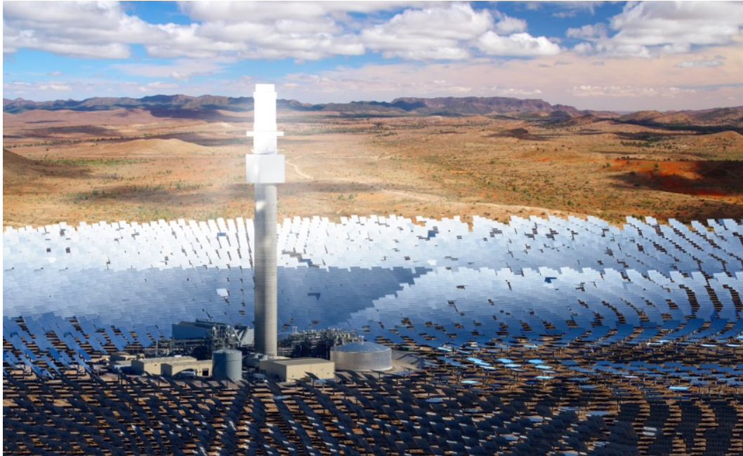
Figura 2.17 - Exemplo de uma central Heliotérmica do Tipo Torre Central. Fonte: Fonte (ARCH DAILY, 2014).
