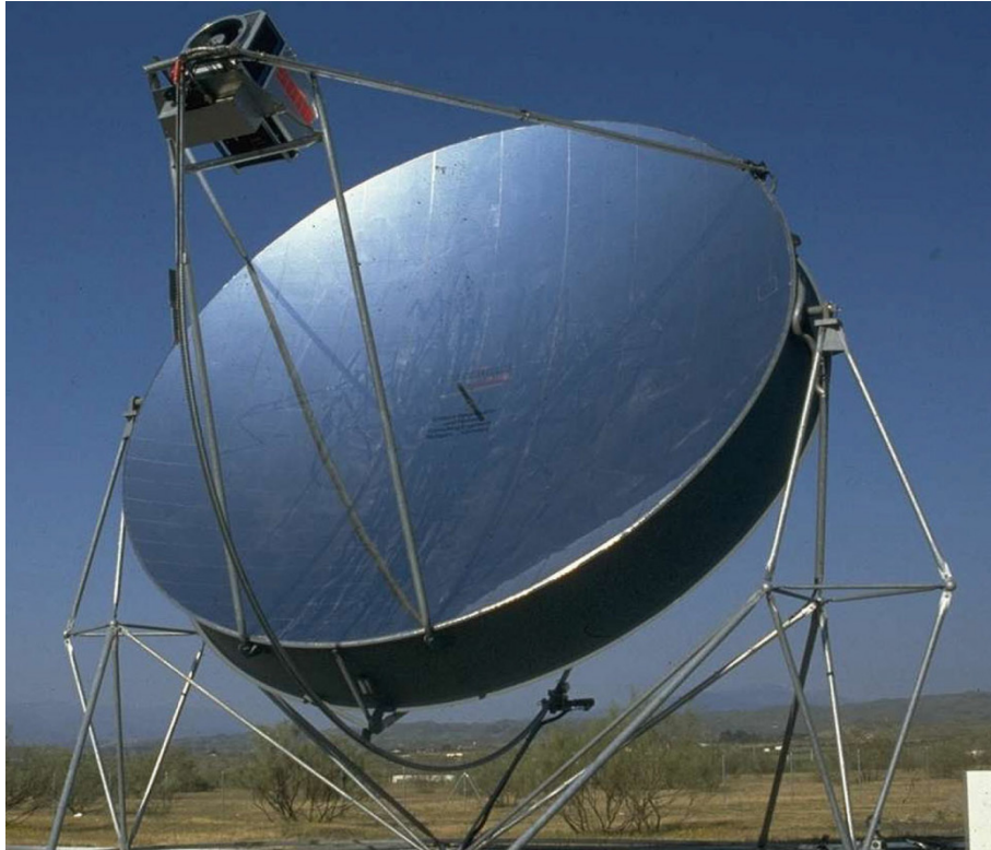
Figura 2.30 - Sistema Dish Stirling do projeto Distal II, Almería, Espanha. Fonte: (SBP - SCHLAICH BERGERMANN PARTNER, 2017).
