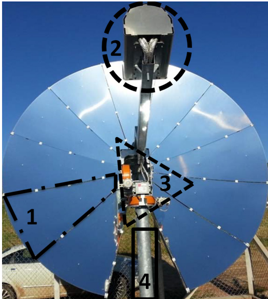
Figura 3.1 - Componentes do Sistema Dish Stirling Trinum.
