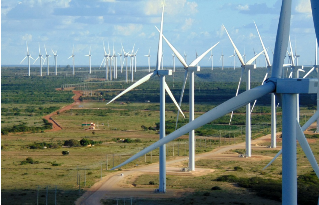
Figura 2.7 – Visão de alguns aerogeradores do Complexo Eólico Ventos do Araripe III. Fonte: (PIAÚÍ HOJE, 2017).
