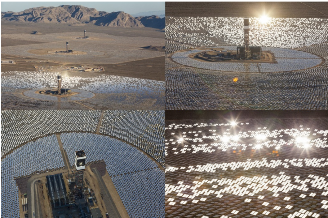
Figura 2.29 - Usina Heliotérmica de Torre Solar de Ivanpah Solar Electric Generating System, Primm California-EUA.
