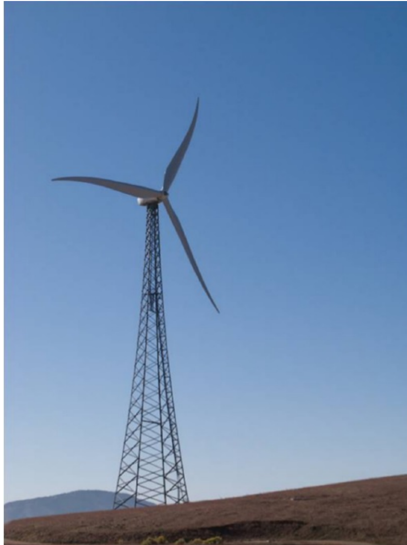
Figura 9 – Turbina de Eixo Horizontal do rotor STAR, com efeito sweep nas pás, em Tehachapi, EUA.
