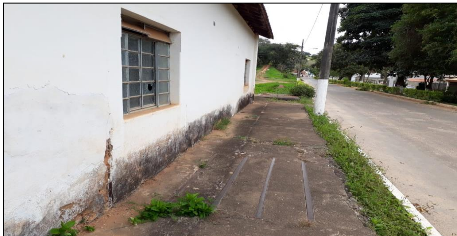
Imagem 09: Marcas dos trilhos
