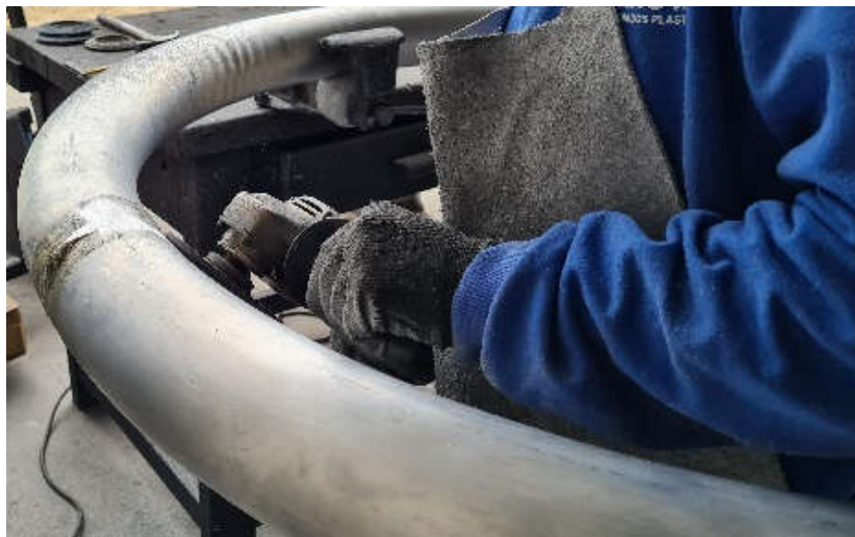
Figura 26 - Processo de remoção do reforço Fonte: Autor 2021
