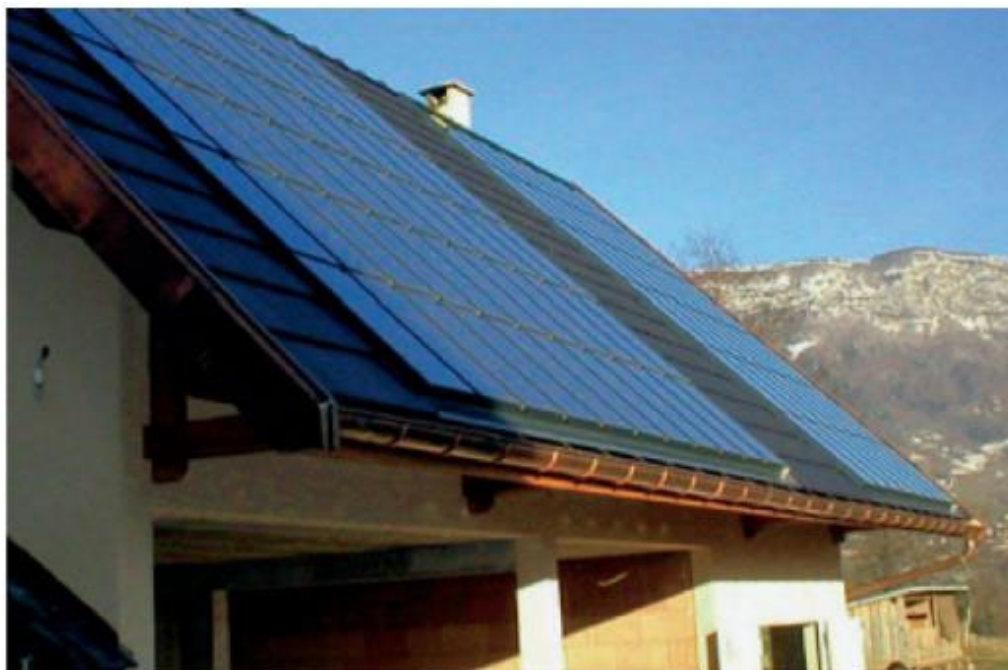
Figura 2.39 - Exemplo de um SFCR descentralizado. Fonte: (JANNUZZI, VARELLA e GOMES, 2009)
