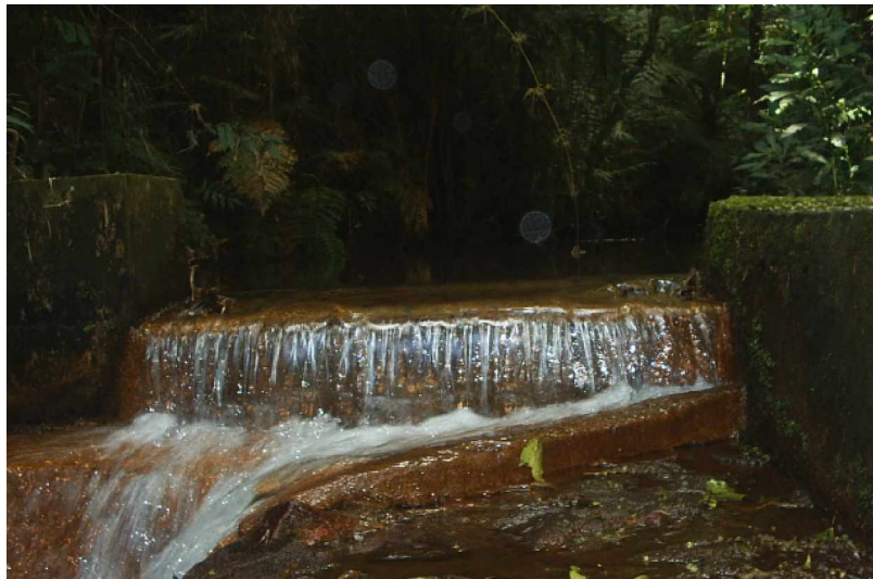
FIGURA 4.2 - Dique vertedouro de derivação visto de frente
