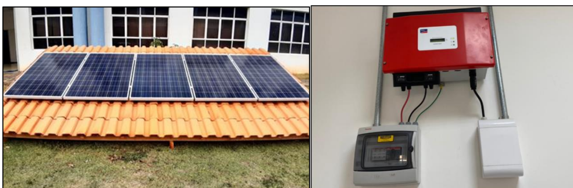
Figura 4.11 Sistema fotovoltaico LTPFV, instalado no campus da UNIFEI, a esquerda a instalação dos módulos sobre o telhado, a direita o inversor conectado à rede
