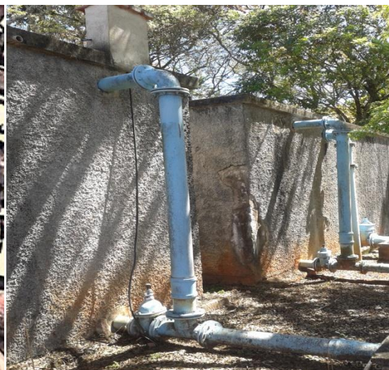
Figura 18b – Reservatório Solar dos Lagos
