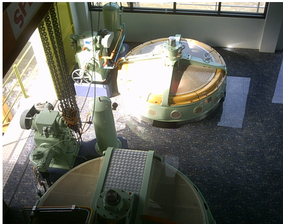
Figura 2.8 – Turbina Francis Caixa Aberta – Grupo Gerador da MCH Boa Vista, RS
