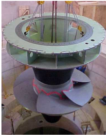
Figura 2.15 (b) - Rotor de uma turbina Kaplan
