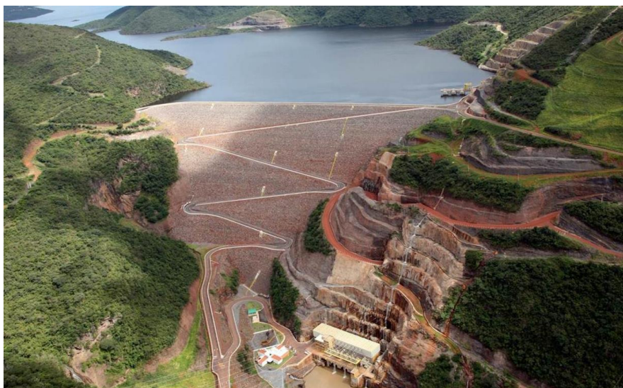
Figura 3-5 – Barragem em enrocamento (Fonte: UHE Irapé – CEMIG)
