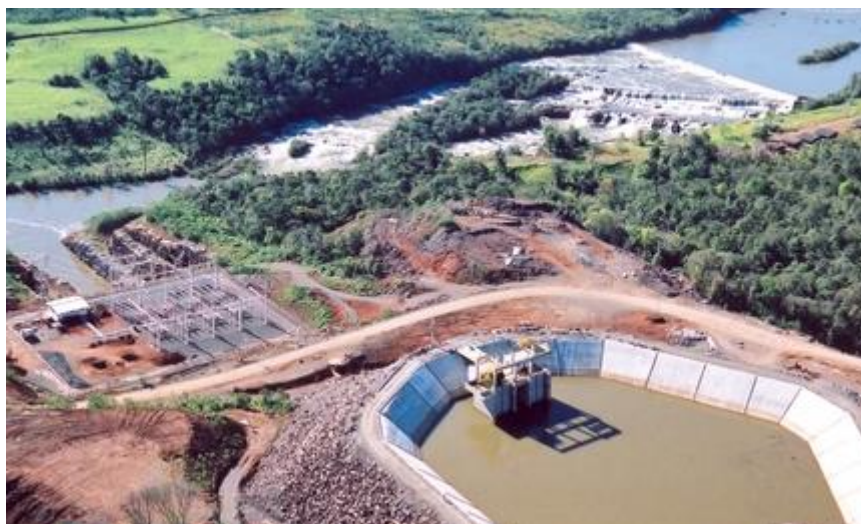
Figura 3-11 - Câmara de carga revestida em concreto (Fonte: UHE Santa Clara)
