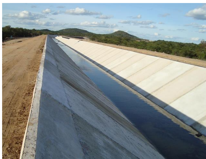
Figura 3-9 - Canal em concreto encosta pouco íngreme (Fonte: Transposição rio São Francisco)
