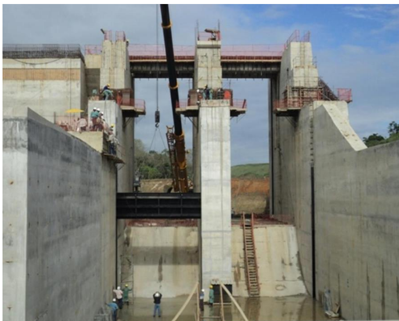
Figura 3-15 - Vista jusante montagem comporta enscadeira (Fonte: PCH Pacanabi)
