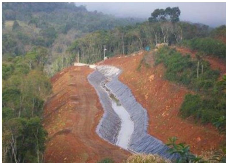
Figura 3-10 - Canal escavado em solo com manta impermeável (Fonte: CGH Aurora - COMAX)
