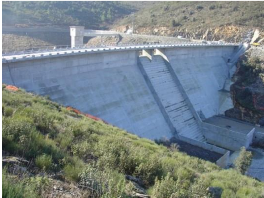
Figura 3-3 – Barragem em concreto (Fonte: DTGR Barragem da Ferradosa 2007)
