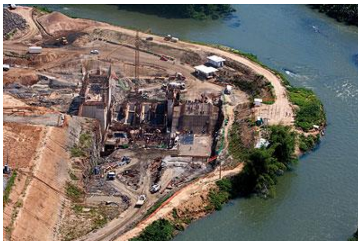
Figura 3-13 – Ensecadeira em solo (Fonte: PCH Paracambi)
