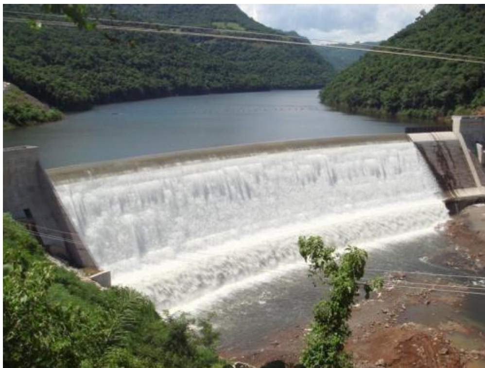
Figura 3-6 – Vertedouro Livre (Fonte: UHE Castro Alves – CERAN)
