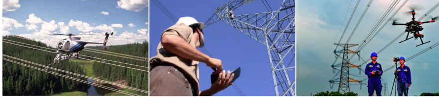
Figura 3 – Modos comuns de inspeção em linhas de transmissão de energia Fonte: (RESENDE, 2017; RANGEL; KIENITZ; BRANDÃO, 2009)
