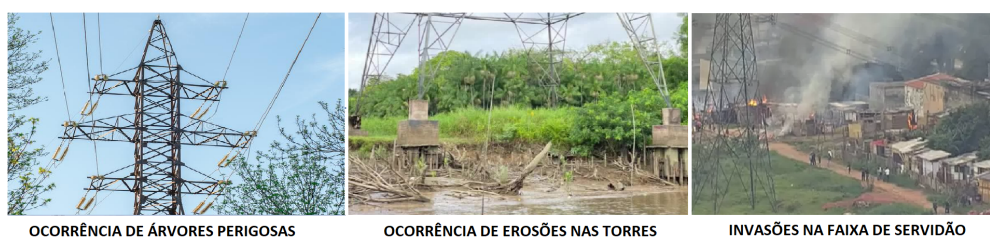
Figura 2 – Ocorrências comuns no ambiente próximo a linha de transmissão de energia. Fonte: (SILVA, 2011; GLOBO, 2019) Adaptado
