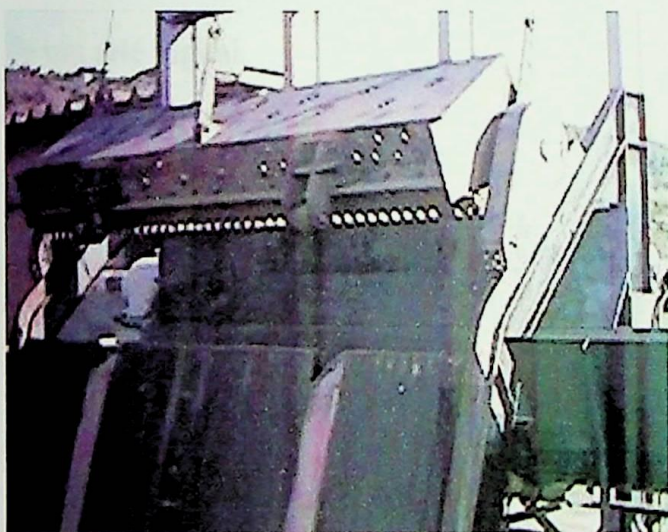
Figura 37: Sistema de Limpeza de Grade Automático, Central Eloy Chaves.
