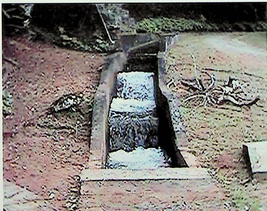
Figura 2.6 – Canal adutor do Ribeirão Quilombo
