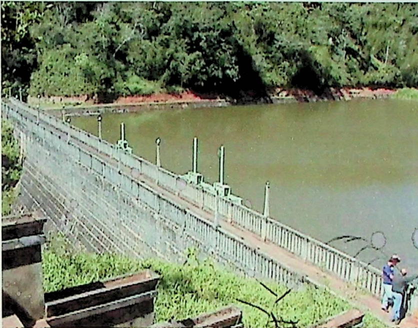
Figura 2.14 – Reservatório de 1932. Paramento seco
