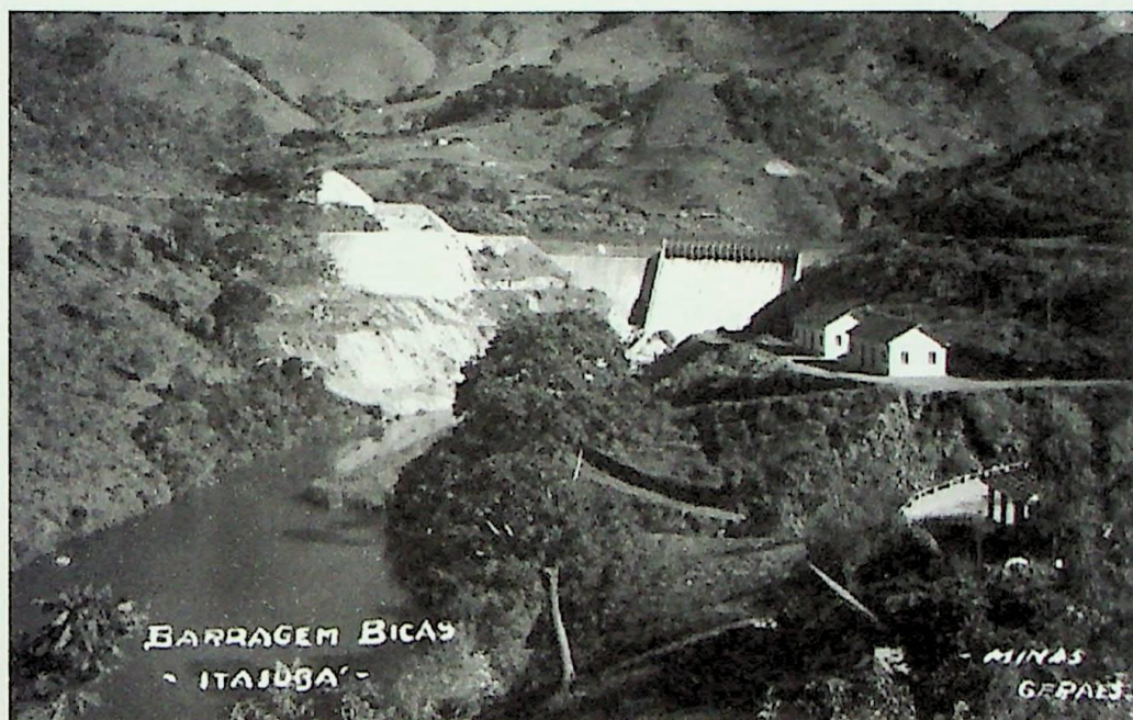
Figura 2.42 – Barragem concluída na década de 60
