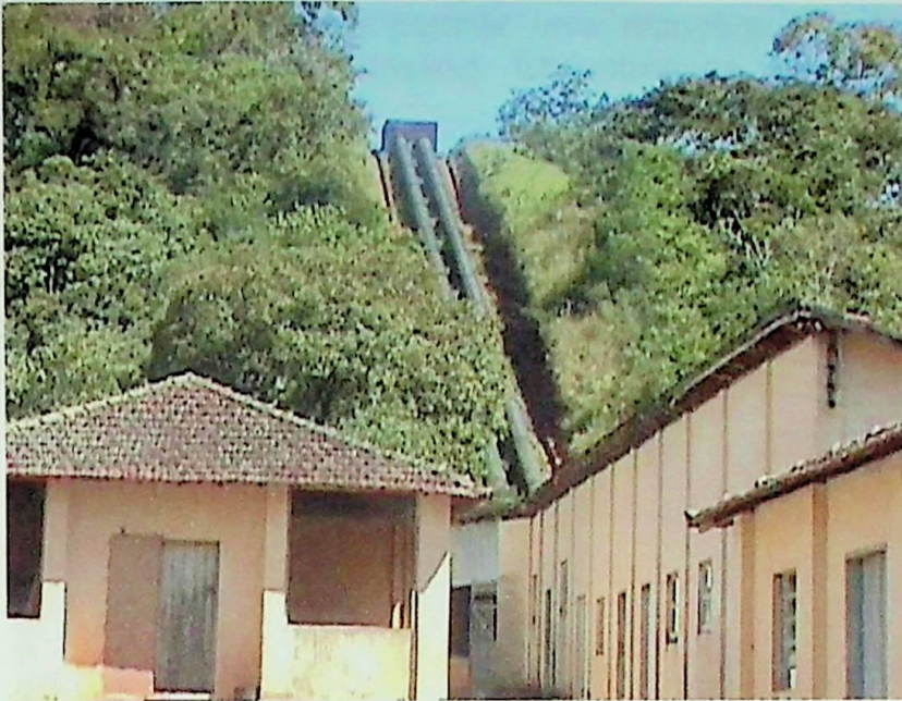
Figura 2.20 - Trecho final dos condutos forçados
