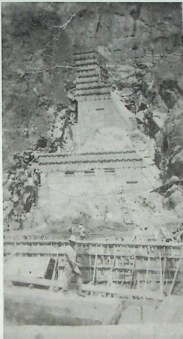
Figura 1.6 – Construção da barragem
