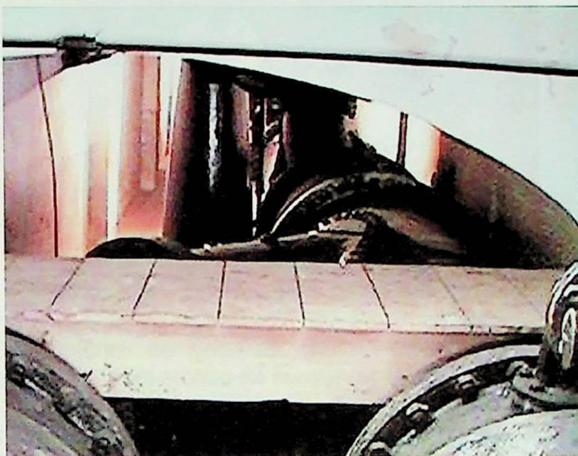
Figura 2.22 – Conexão Y da tubulação forçada
