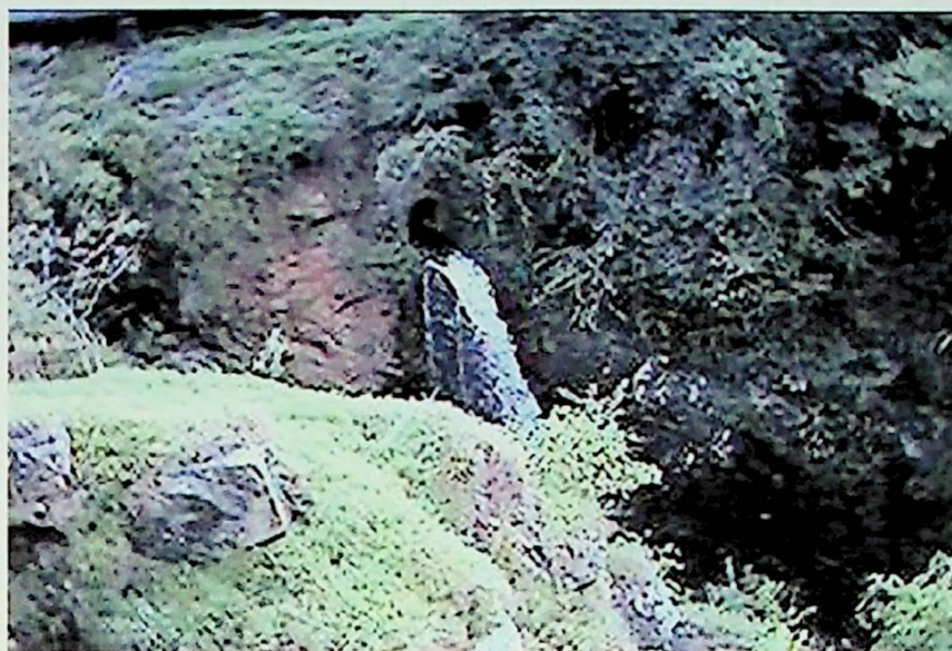
Figura 2.17 – Final do túnel de descarga, local da antiga Cachoeira dos Negros
