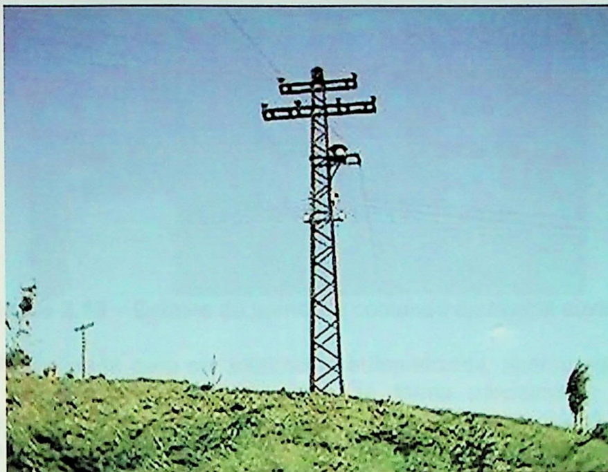
Figura 2.12 – Torres de transmissão
