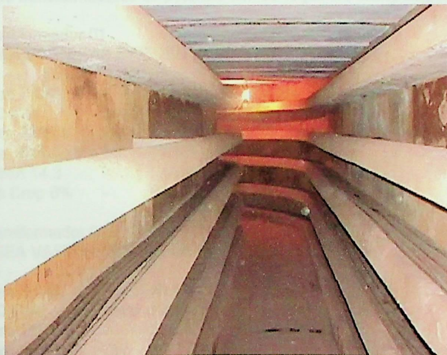
Figura 2.33 – Túnel sob o piso entre a casa de máquinas e a subestação da CP
