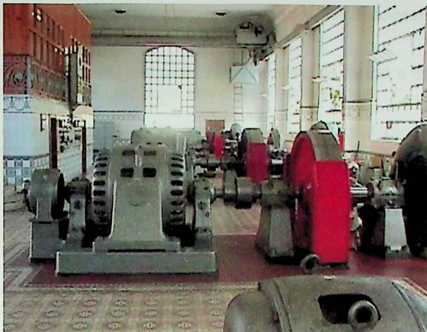
Figura 2.29 – Disposição dos GG da central principal
