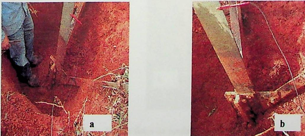
**Fig.7.6.1 – Estado físico da fundação da torre 305**
