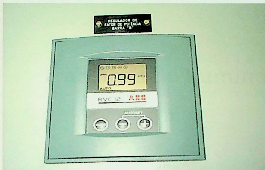
Figura 3.4 – Controlador de fator de potência da barra alimentadora área processo
