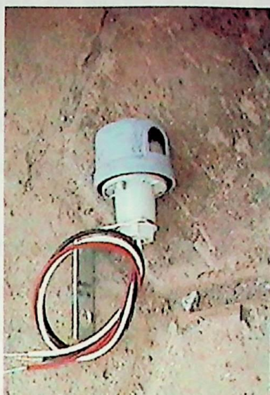
Figura 5.12 Relé fotoelétrico para comando individual
