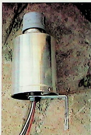
Figura 5.13 Relé fotoelétrico para comando em grupo
