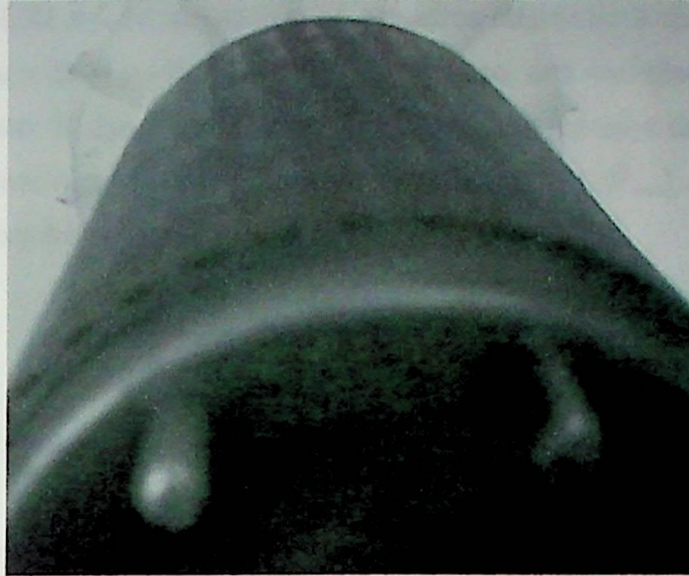
Figura 6.22: Rotor com as barras em boas condições
