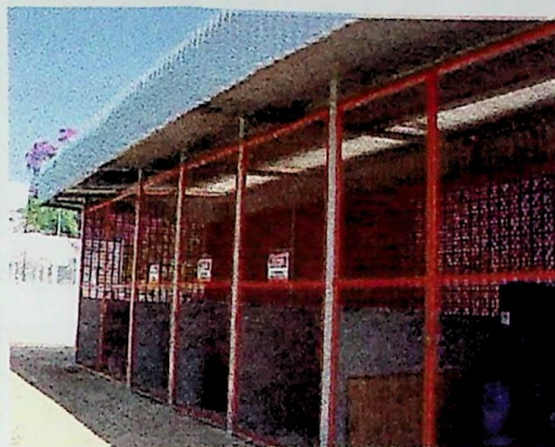
Figura 4.4.6.2 – Depósito de Produtos Inflamáveis
