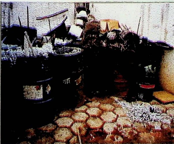
Figura 3.7.5 – Falta de local apropriado para o armazenamento dos resíduos
