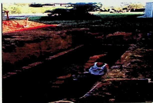
Figura 4.4.6.3 – Construção de bacias de contenção
