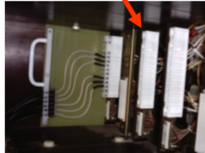
Figura 5.9 – Cabo de testes dos SCR's no compensador estático de reativos.
