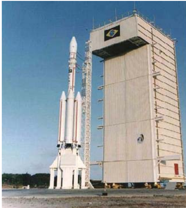
Figura 1.1: VLS-V01 na Plataforma de Lançamento.
