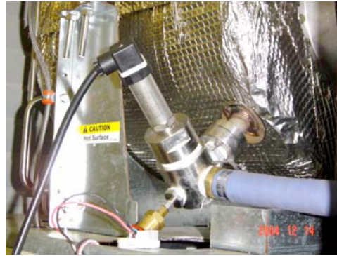
Figura 29 – Medição de Pressão e Temperatura na Saída do Compressor
