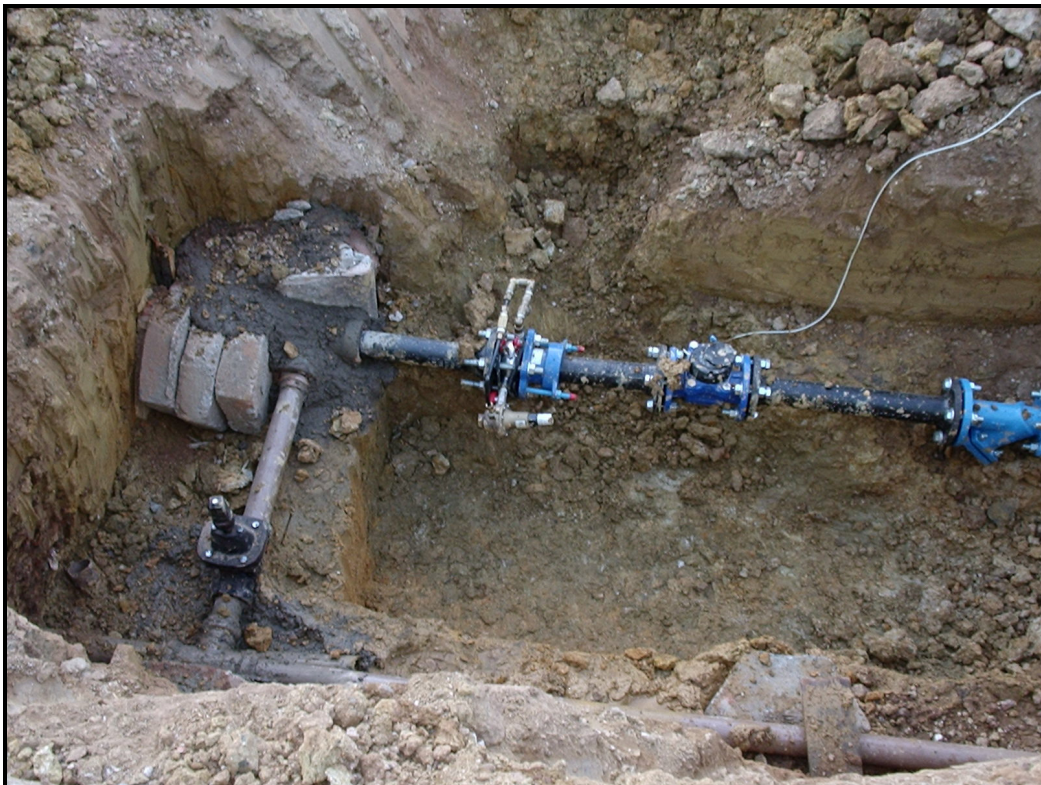
Figura 4.30- VRP e hidrômetro de DN 50 mm
