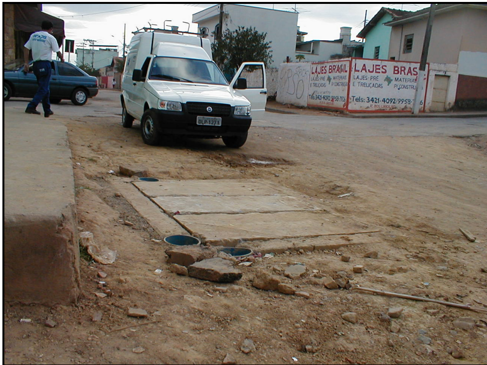
Figura 4.34- Caixa de abrigo da VRP finalizada
