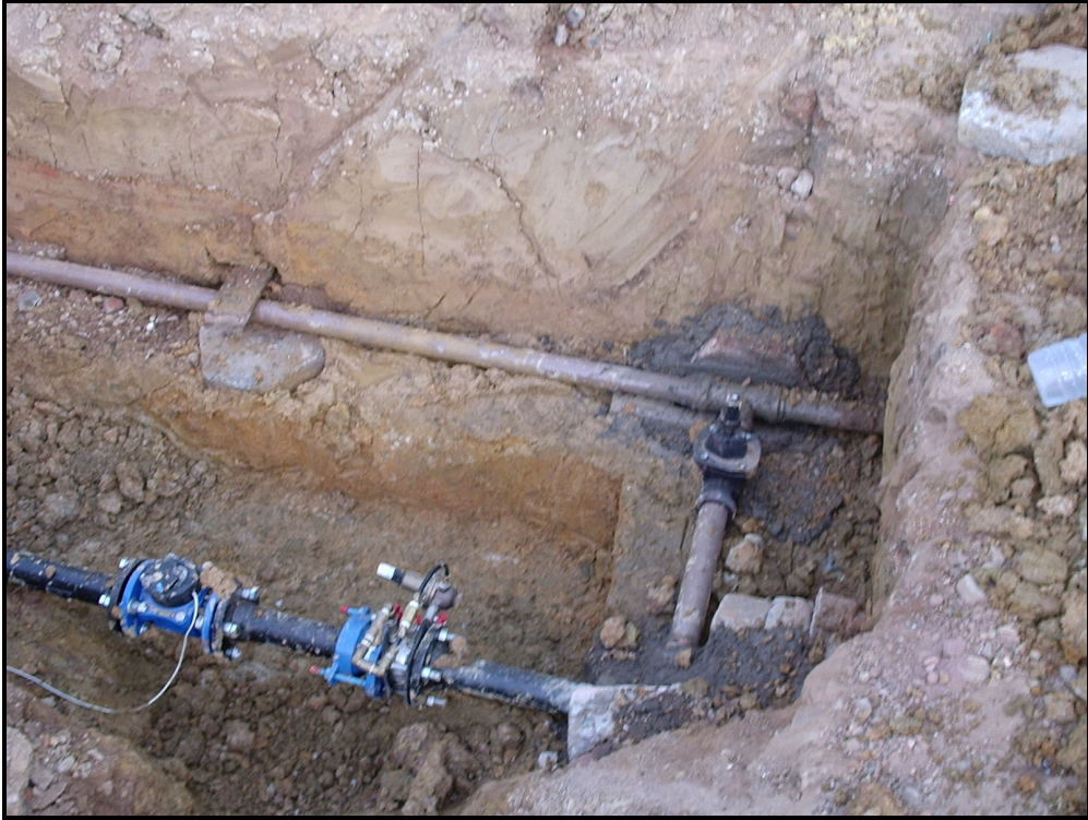
Figura 4.31- VRP e hidrômetro de DN 50 mm
