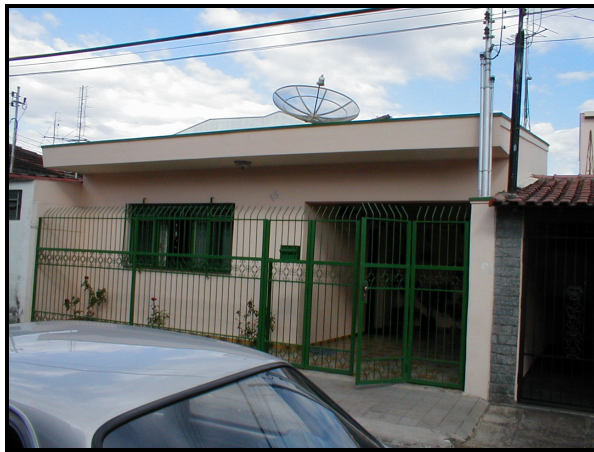
Figura 4.26- Fachada do imóvel da Rua das Rosas, nº 15
