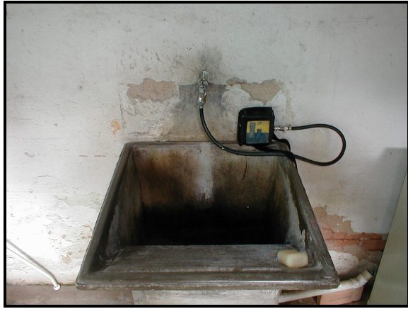
Figura 4.4- Data-Logger de pressão instalado na Rua Cláudio Manuel da Costa, nº 162
