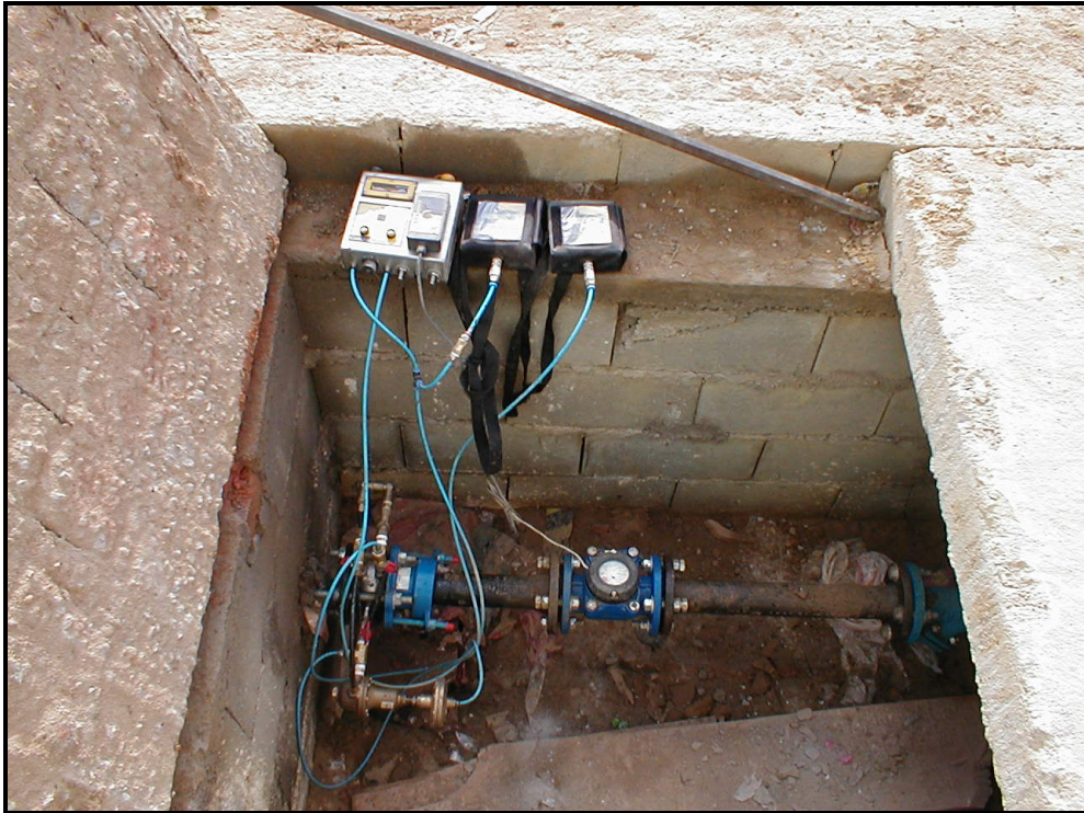
Figura 4.33- VRP montada com circuito de pilotagem permitindo a utilização de controlador modelo descontínuo – Piloto da VRP utilizando o atuador
