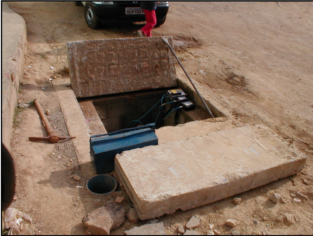
Figura 4.35- Detalhe da laje superior da caixa de abrigo
