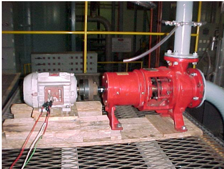
Figura 4.8 – BFT e gerador de indução
