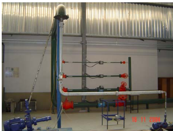
Figura III.1 – Vista geral da linha de recalque, das válvulas esfera, globo e dos medidores eletromagnéticos no Laboratório de Etiquetagem de Bombas (LEB)
