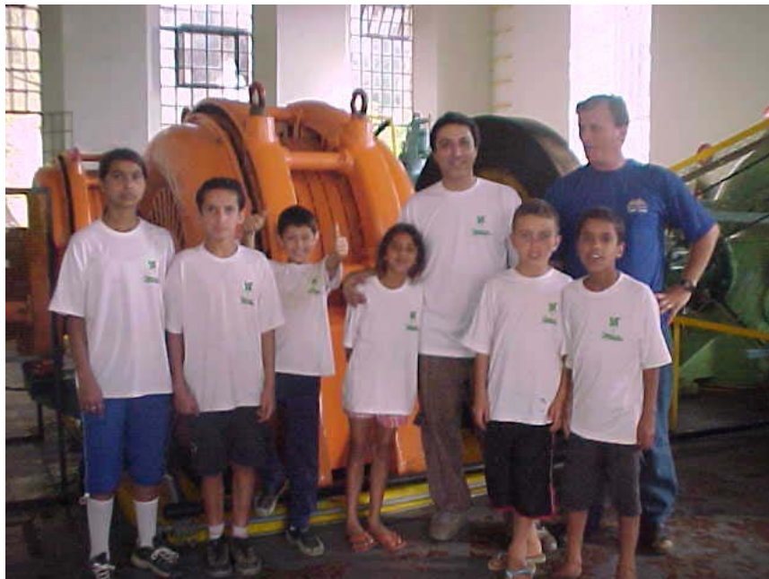
Casa de máquinas da PCH Luiz Dias, turma 2003
