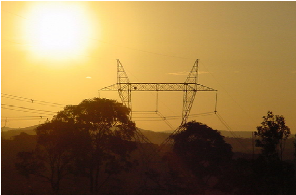
Fig.1.1 – Linha de Transmissão de Energia em Alta Tensão
