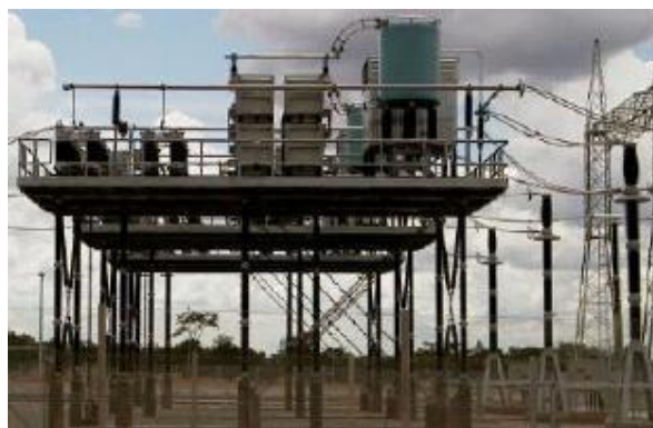
Fig.3.4 – Foto de uma Compensação Série Fixa (CSF) instalada
