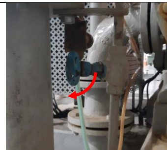
Fig. 23- Válvula de alimentação do cálice
