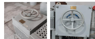
Fig. 28 - Reostatos (R1 e R2)
