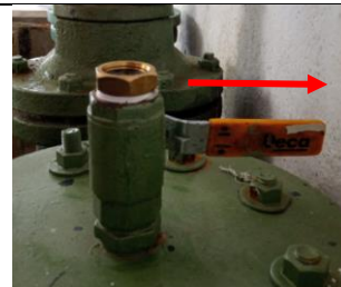
Fig. 4 - Válvula de purga (V2).
