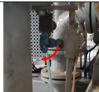
Fig. 22 - Válvula de alimentação do cálice
