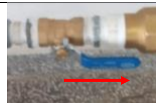
Fig. 43 - Válvula esférica (V10).
