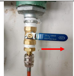
Fig. 7 - Válvula esférica de alimentação de ar (V5).
