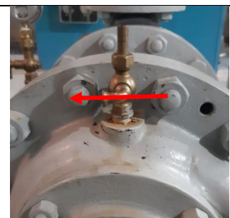
Fig. 21 - Válvula de suspiro
