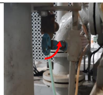
Fig. 17 - Válvula de alimentação do cálice
