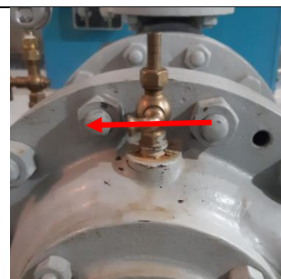
Fig. 20 - Válvula de suspiro.
