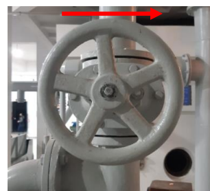
Fig. 3 - Válvula de saída da bomba (V1).
