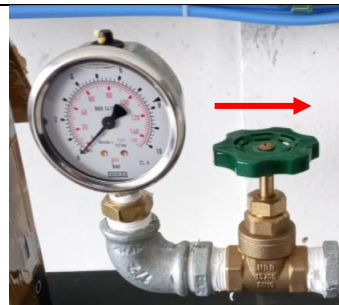
Fig. 12 - Válvula gaveta do manômetro M3 (V10).
