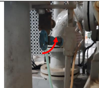
Fig. 17 - Válvula de alimentação do cálice.
