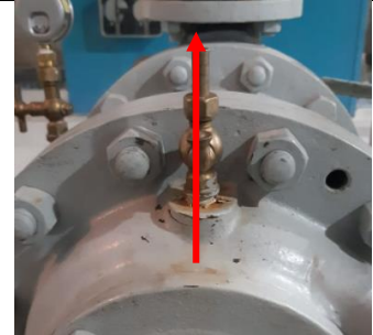
Fig. 15 - Válvula Suspiro.
