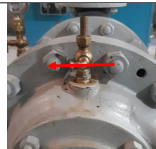
Fig. 20 - Válvula de suspiro
