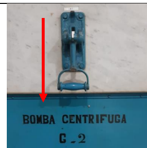
Fig. 56 - Chave da bomba (B1).
