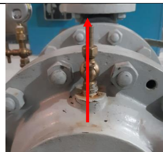
Fig. 15 - Válvula Suspiro
