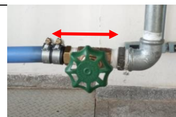
Fig. 38– Válvula (V12) de ajuste de vazão.
