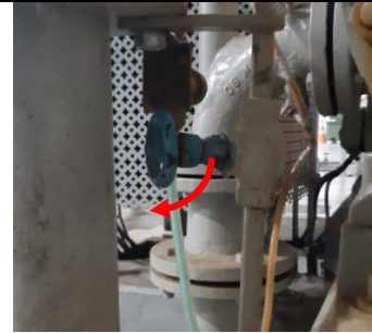
Fig. 22 - Válvula de alimentação do cálice.
