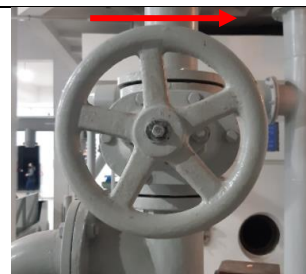
Fig. 3 - Válvula de saída da bomba (V1)
