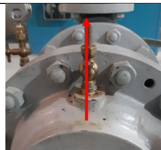
Fig. 16- Válvula Suspiro
