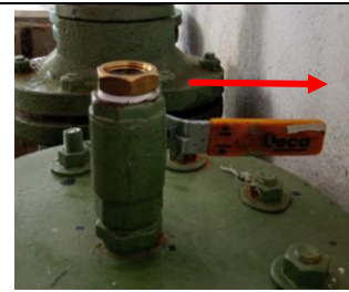
Fig. 3 - Válvula de purga (V2)
