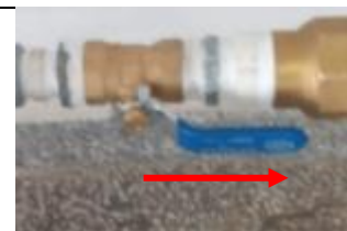
Fig. 44 - Válvula esférica (V6).
