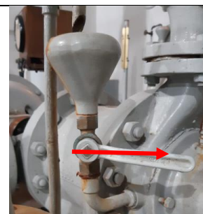
Fig. 21 - Válvula do cálice.
