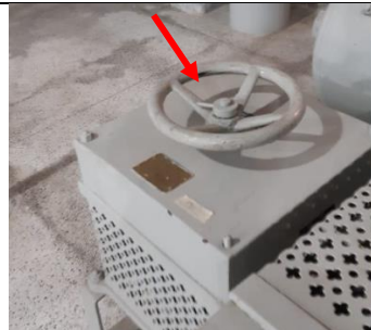
Fig. 19 - Reostato de ajuste fino (R1)
