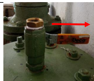
Fig. 4 - Válvula de purga (V2)
