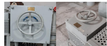
Fig. 27 - Reostatos (R1 e R2).
