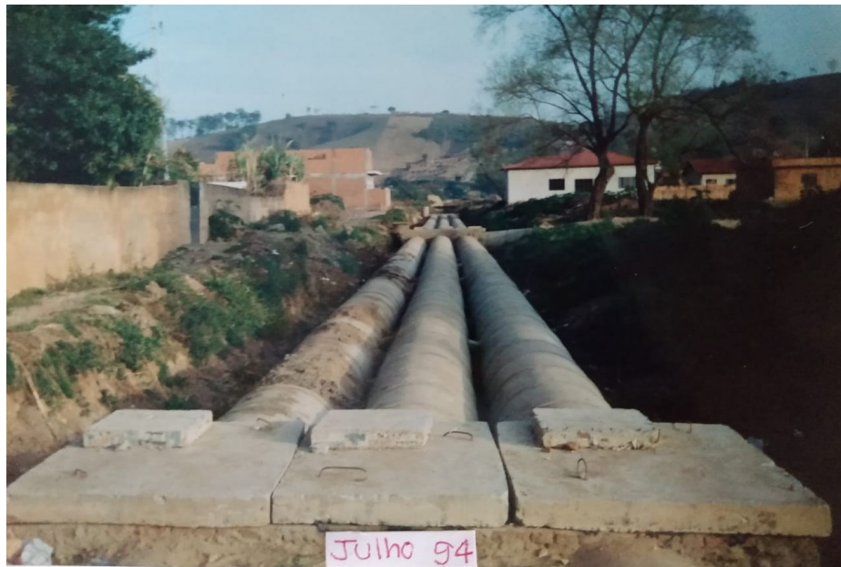
Figura 4.10 - Trecho do ribeirão Água Preta em canal fechado Fonte: AMBVR (2021)
