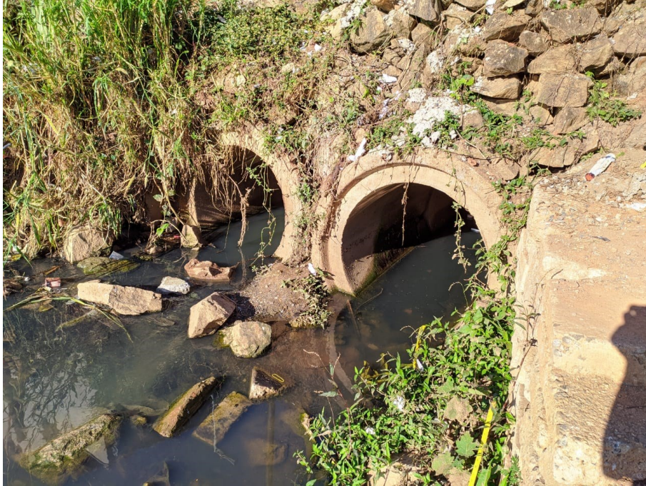
Figura 4.11 - Final do trecho em canal fechado do ribeirão Água Preta
