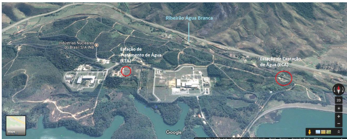
Figura 14 - Localização do sistema de captação e tratamento de água da FCN.
