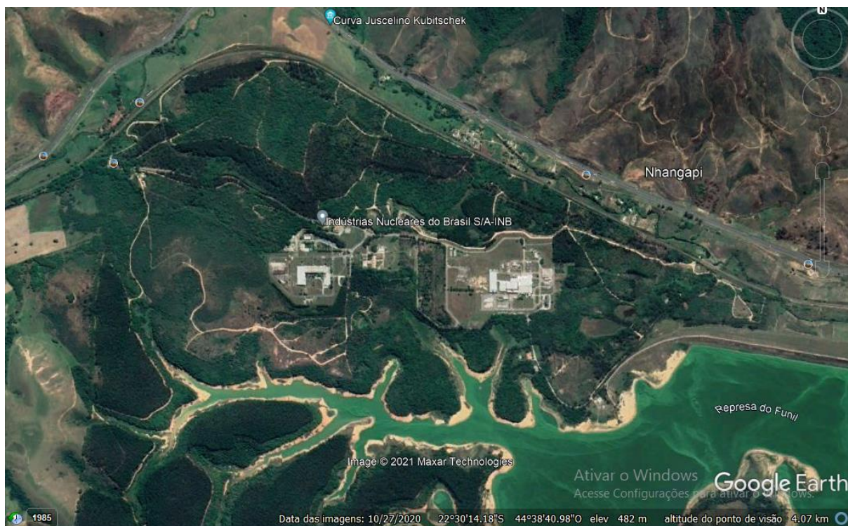
Figura 12 - Vista aérea da área total da FCN. Fonte: Google Earth.
