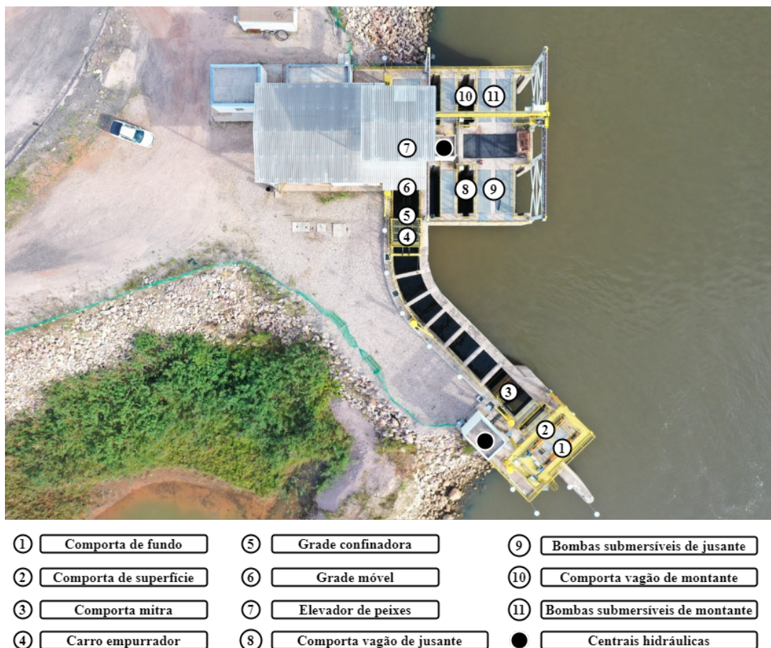
Figura 19 – Principais equipamentos do STP da UHE de Sinop.
