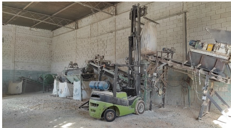
Figura 23 – linha de moagem dos resíduos de vidro da empresa RANENI de Varginha-MG.
