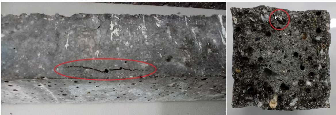
Figura 60 – Presença de RVM e sinais de fissura, estufamento e manchas brancas em barra do traço AAA 5 RVM Fonte: próprio autor
