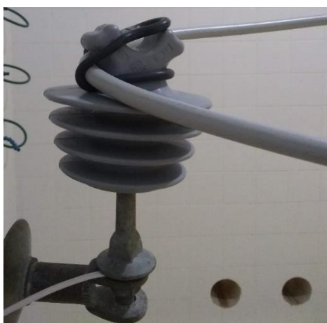
Figura 50 –Cabo coberto instalado sobre o isolador polimérico durante o ensaio de envelhecimento. Fonte: próprio autor.
