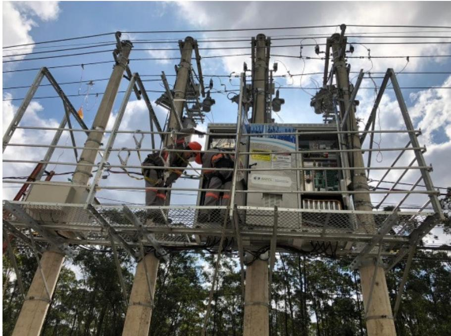
*Figura 54. VSC trifásico desenvolvido em uma instalação ao tempo - Teste em campo em 13,8 kV.*
