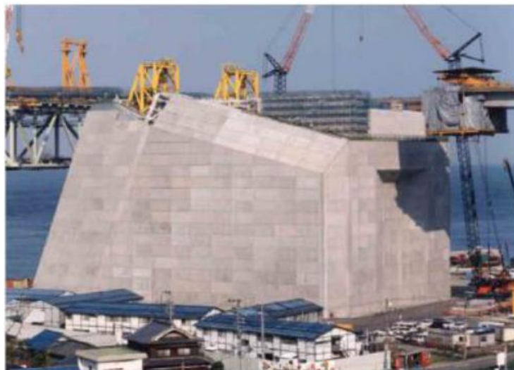
Figura 2 - Bloco de ancoragem da ponte Akashi-Kaikyo
