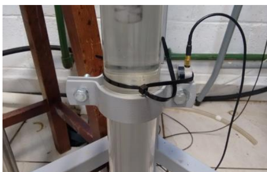
Figura 3-12: Transdutor ultrassônico instalado na seção inferior da tubulação (estação 2).
