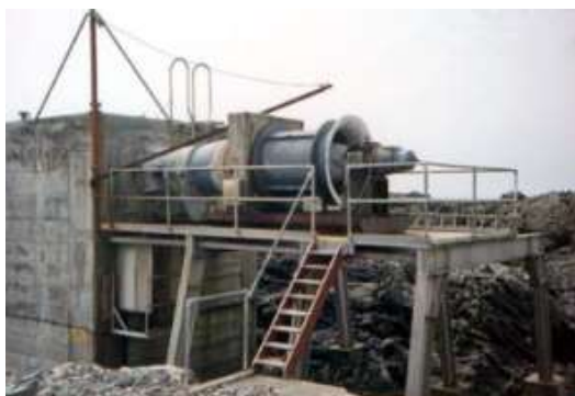
Figura 2.6 – Fotos do protótipo de UCAO de 75 kW de potência em Islay, na Escócia
