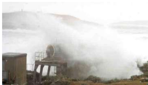
Figura 2.6 – Fotos do protótipo de UCAO de 75 kW de potência em Islay, na Escócia
