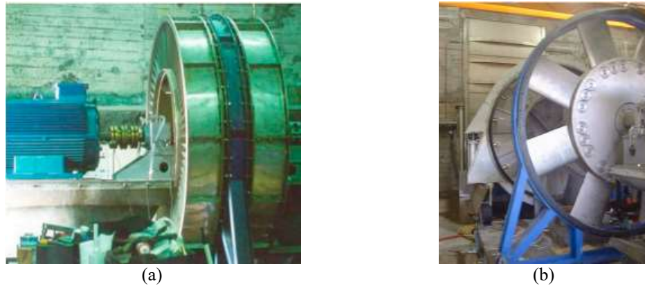
Figura 2.19 – Usina do Pico: (a) Conjunto gerador (b) Turbina Wells Fonte: Bruschi et al. , 2019
