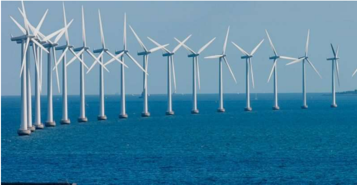
Figura 7 – Usina eólica offshore .
